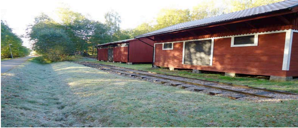
Renoverade stationsmagasin vid Olsäters nedlagda järnvägsstation 2014
