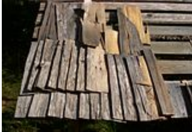
Läggning av spåntak (Wikipedia)
